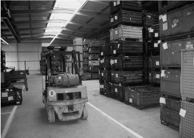
Bild 1: Industrieboden aus Beton mit Staplerverkehr
