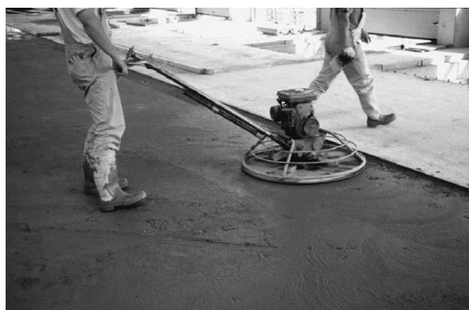
Bild 6: Maschinelles Abscheiben der Betonoberfläche
